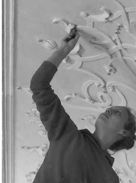
Reinigungsarbeiten an der Decke (Foto: VB)
