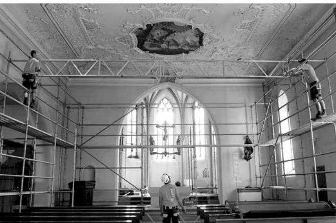
Einrüstung (Foto: Valentine Baur)
